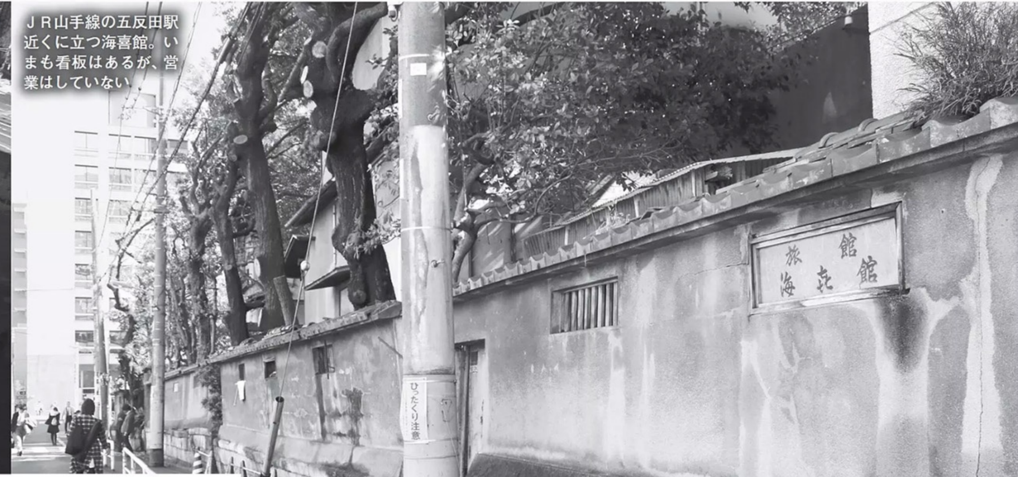
海喜館は目黒川沿いに立ち、敷地内には緑が多い。うっそうとした雰囲気である
